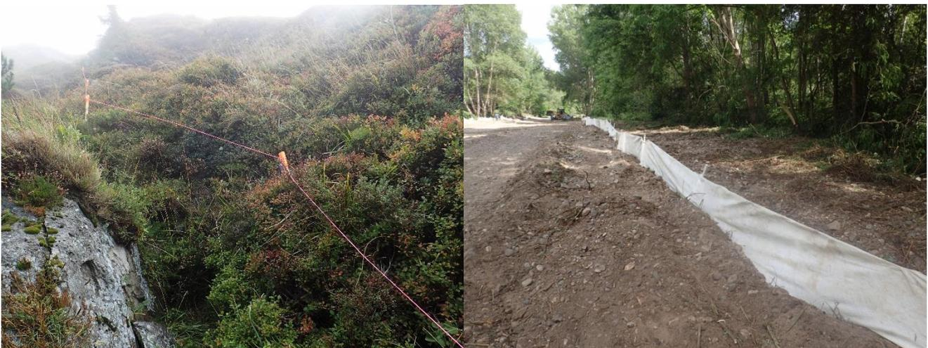
**Figure 21. Exemples de mise en défens de zone sensible et clôture de protection temporaire en phase chantier (Source Crexeco)**
