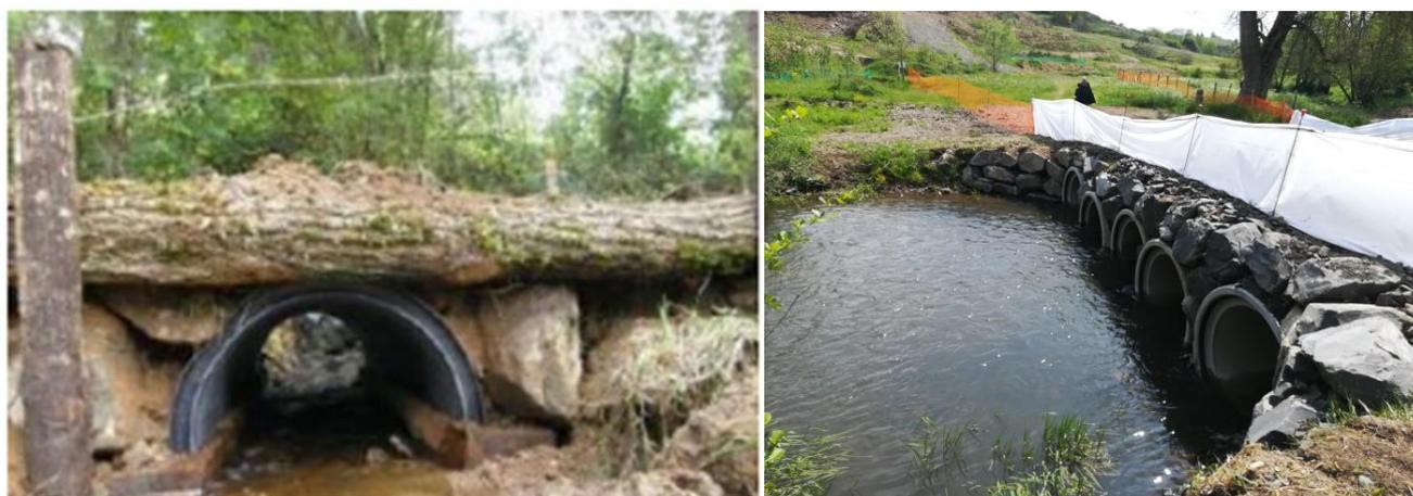
Figure 23. Exemples de franchissement de cours d'eau aménagés pour le bétail et dispositifs de limitation de dispersion des fines
